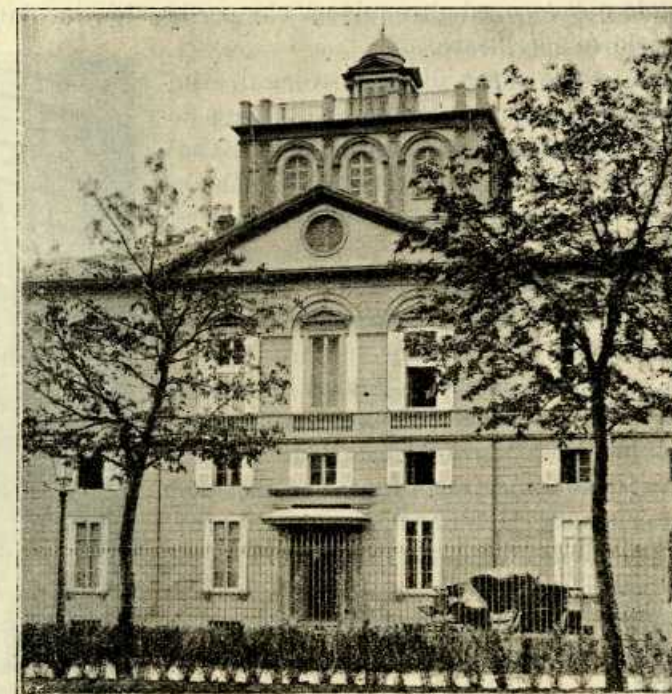
PALAZZINA QUAGLIA sul Corso Valentino .
